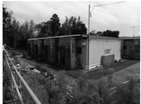
玄関を改良した仮設住宅 (三日市)
