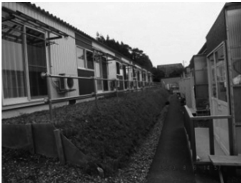
段差をつけた仮設住宅 (賤当)
