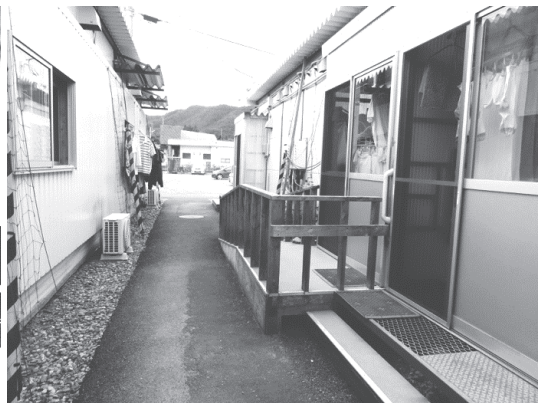
玄関板は金属に変えたが木製の手すりも腐食が多い（牧田団地）
