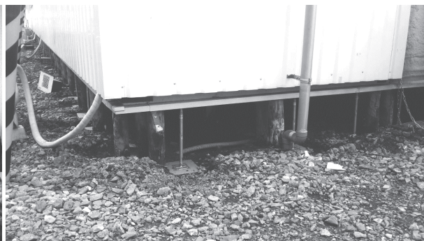
県による補強工事（鉄の板と棒による支え） （米崎小団地）
