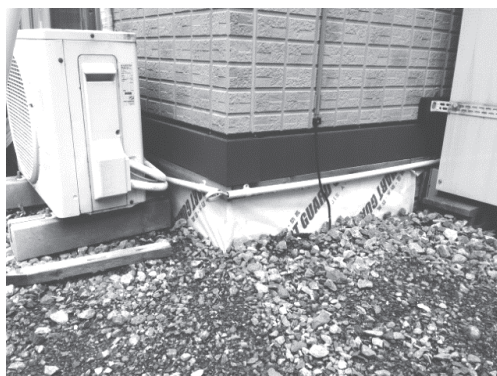
基礎の補強工事とエアコン室外機（下壺）
