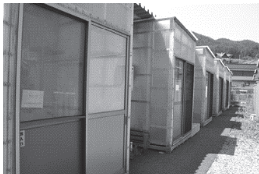
扉に「空き室」の白い張り紙が並ぶ仮設住宅 (要谷団地)
