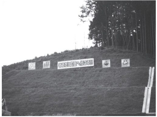
隣接地では新たな県道の工事が進む (旧広田水産団地)
