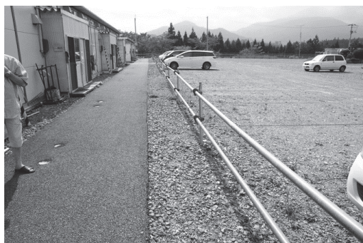
空き住戸周辺にのみ除草剤を散布（仲の沢団地）
