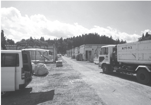
解体作業が進む高田1中グラウンド仮設
