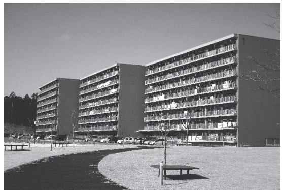
栃が沢災害公営住宅の風景
