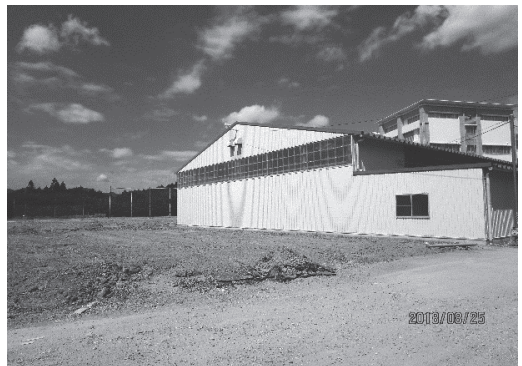
解体・撤去が終了した長砂（高田高校第2グラウンド）仮設住宅団地跡
