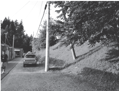
草刈りを行った団地内の斜面（下壺）
