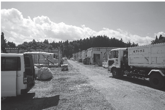
解体・撤去作業が進む高田1中仮設住宅団地
