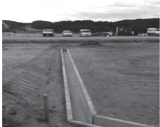
進む広田町の高台移転地の造成
