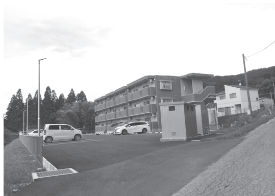
相川団地周辺に建設されたアパート
