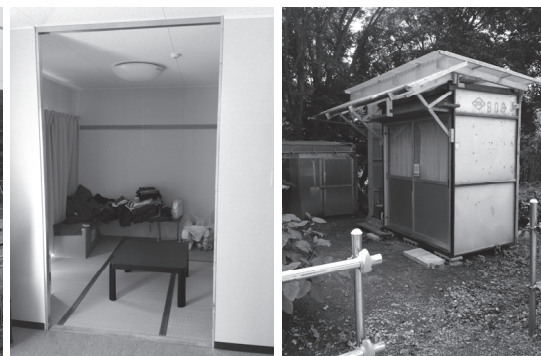
狩集団地の環境変化 （左：集会所、右：団地内倉庫）
